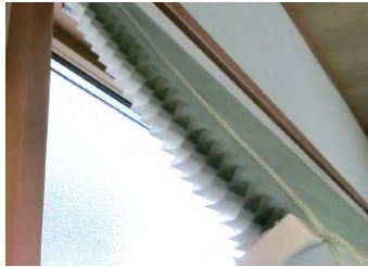
▲ハニカムは「ハチの巣」という意味。ハニカムスクリーンは立体的な空気層で断熱し、窓辺の冷気や熱気を遮ります。
