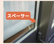
▲複層ガラスやトリプルガラスの見分け方：ガラスの間にスペーサーが挟まれています。
