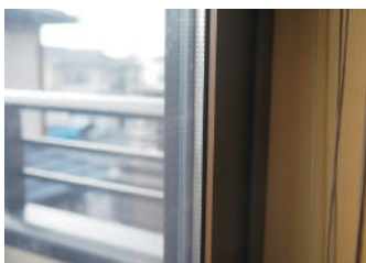
▲夏の暑さを遮る複層Low-Eガラス。ガラス板の間にはアルゴンガスが充填され、断熱性が高くなっています。
