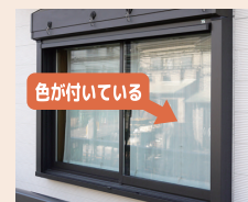
▲夏の太陽熱を遮るLow-Eガラスの見分け方：金属膜でコーティングされているので少し色が付いています。
