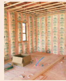
▲壁の内部に断熱材を充填している様子
